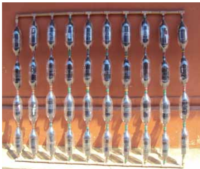
Figura 2: Montagem do painel solar.
