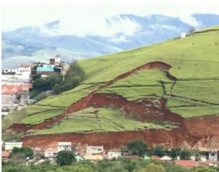
Figura 4 - Morro em processo de erosão
