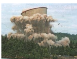
Figura 2. Explosão de dinamite
