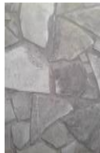
Tijolos, lajotas e pedras
